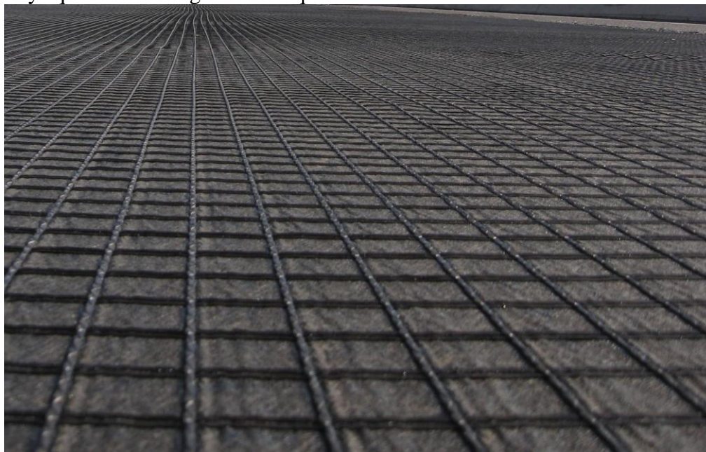
1-rasm. Geosetkani yo‘l poyiga yotqizish jarayonlari
