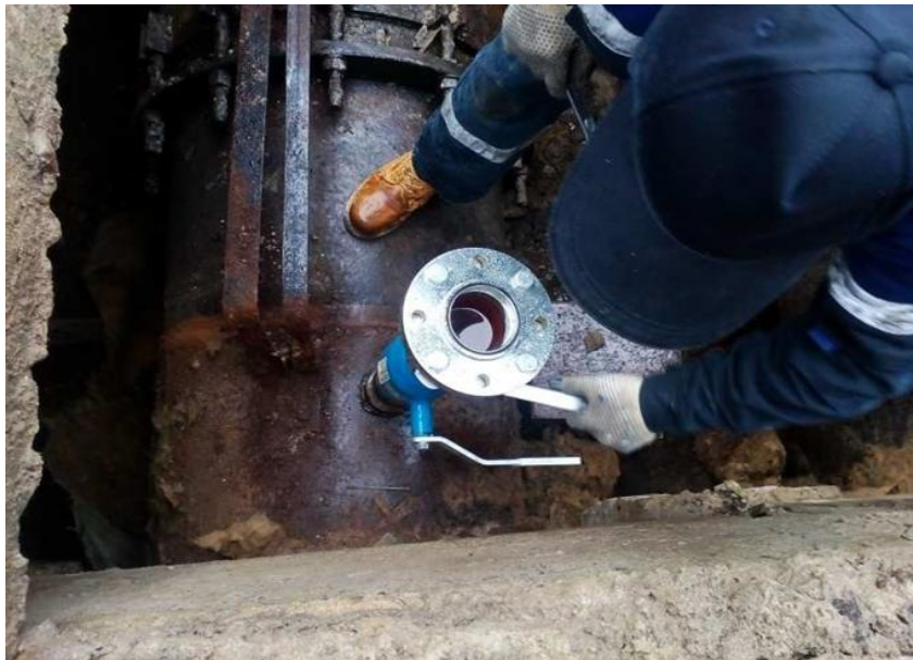
7-rasm. Magistral suv quvuriga shtutser va sharli vintelni o'rnatilishi.
