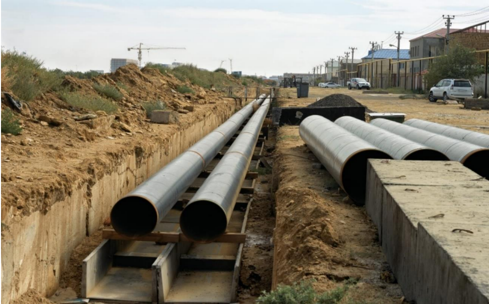
1-rasm. Yangi qurilayotgan ko'p qavatli uylarga komunal xizmatlar ko'rsatish uchun qurilayotgan yangi magistral quvur tarmoqlari
