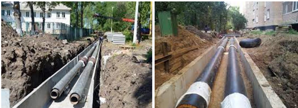
6-rasm. Aholi yashash massivlari uchun qurilgan suv va issiqlik manbai uchun quvurlar
