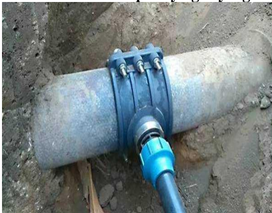
2-rasm. Yangi qurilayotgan ko'p qavatli uylarning suv quvur tarmoqlarini magistral quvurga ulash jarayoni
