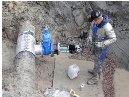
2-rasm. Yangi qurilayotgan ko'p qavatli uylarning suv quvur tarmoqlarini magistral quvurga ulash jarayoni
