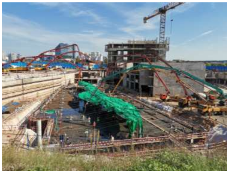
Рисунок 3. Фундаментная плита в процессе бетонирования
