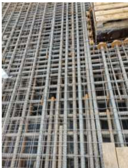
Рисунок 2. Пример армирования фундаментной плиты
